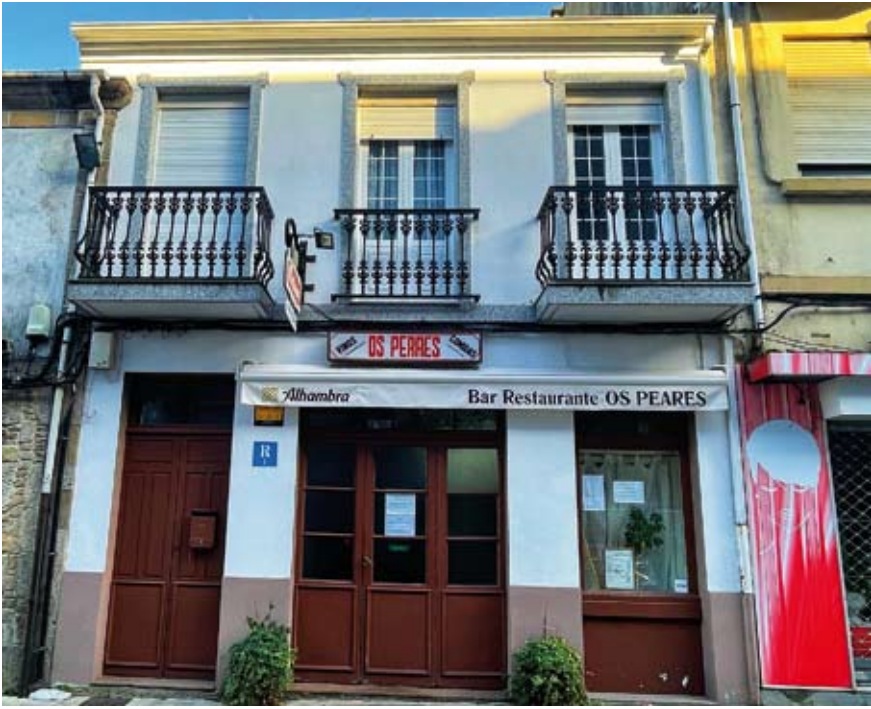
Foto 21. Fachada do nº 5
