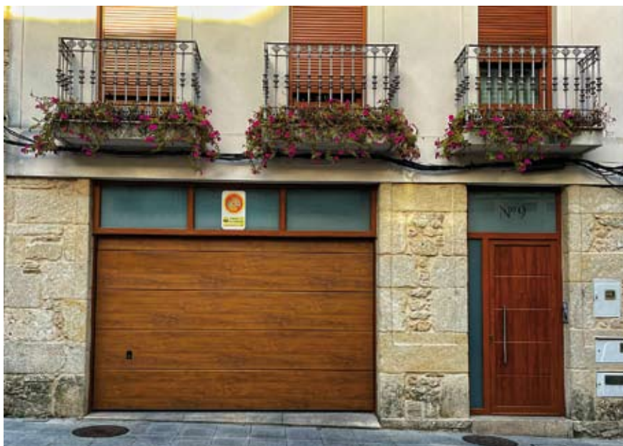
Foto 40. Detalle da fachada
