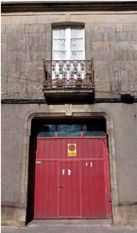
Foto 41. Detalle da fachada
