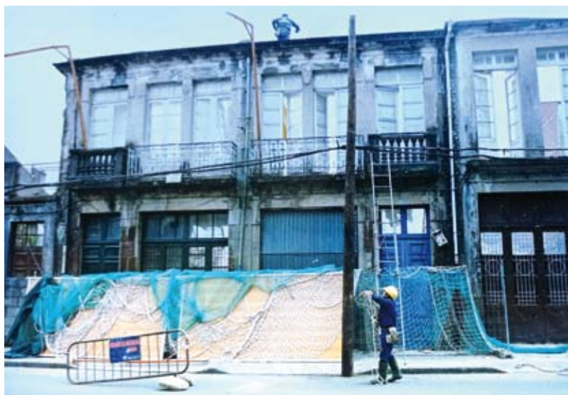
Fotos 6 e 7: Proxecto e imaxe do inicio de demolición
