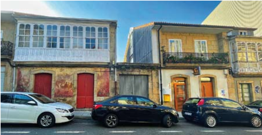
Fotos 29 e 30. Vistas antiga e actual
