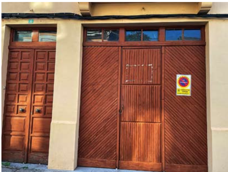
Foto 33. Detalle da fachada do nº 33
