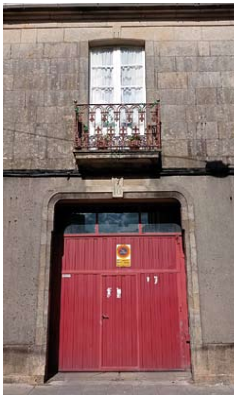
Foto 41. Detalle da fachada
