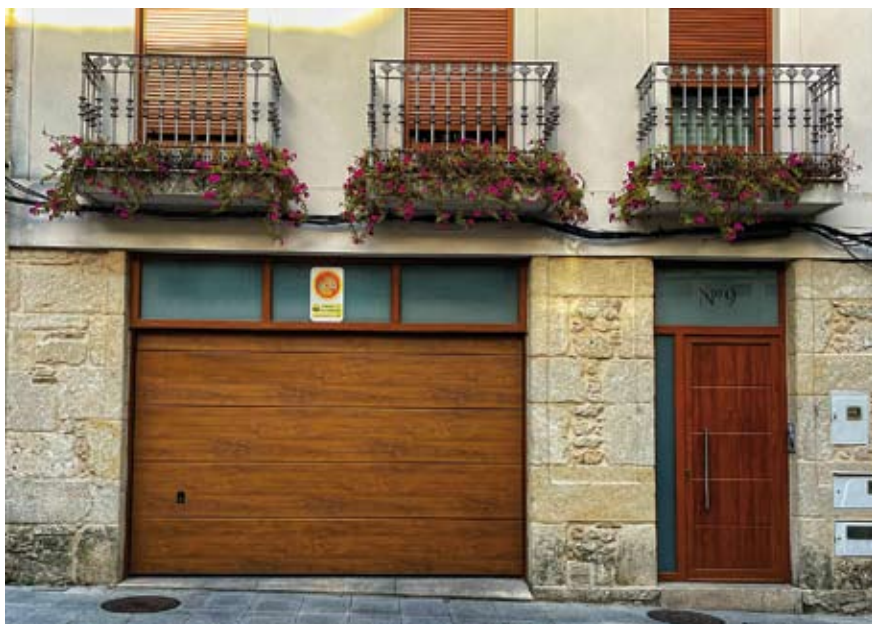
Foto 40. Detalle da fachada
