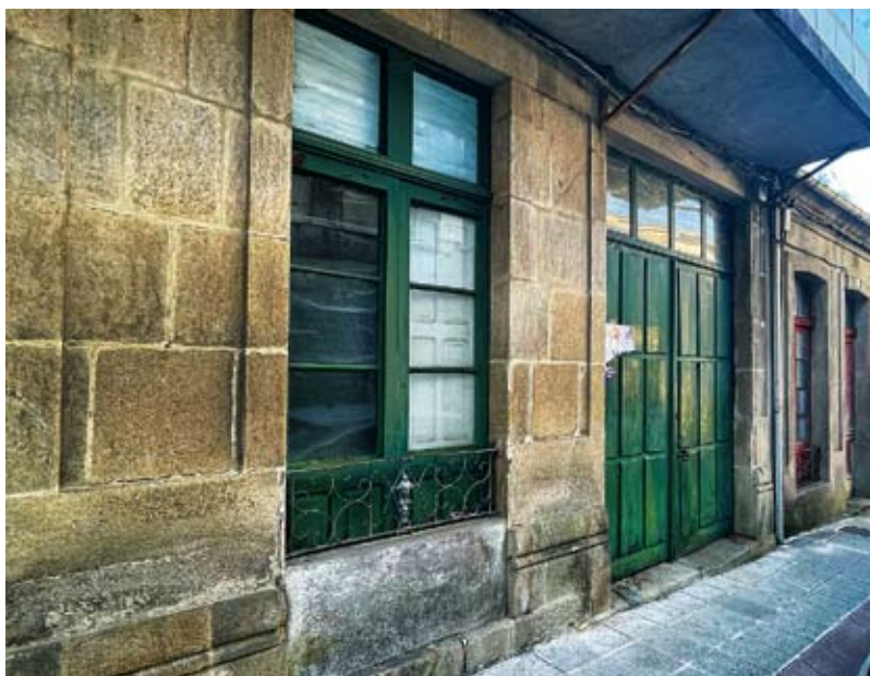
Foto 32. Detalle da fachada do nº 23
